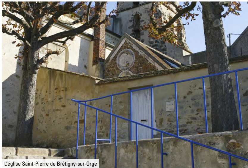
L'église Saint-Pierre de Brétigny-sur-Orge
