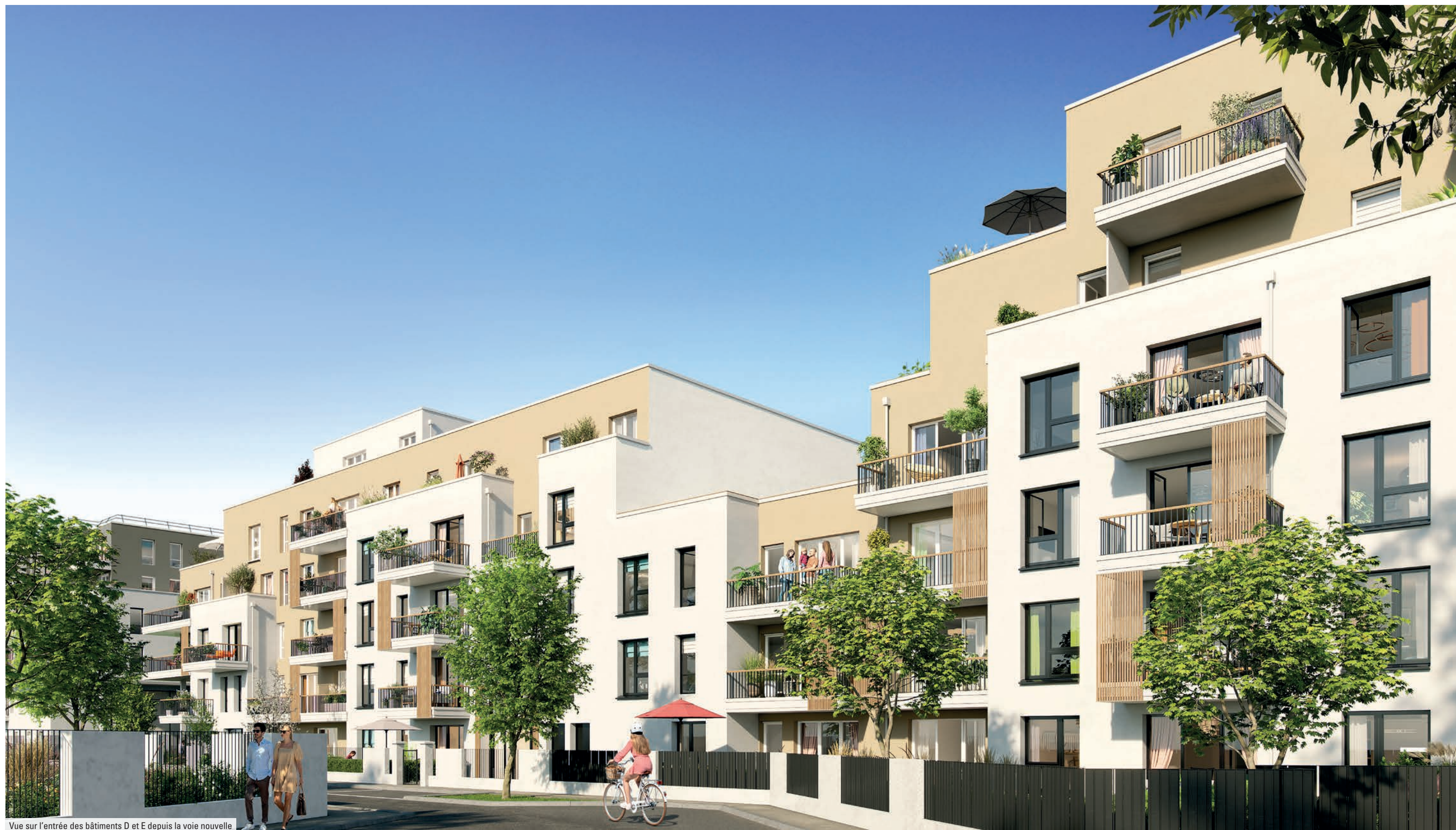
Vue sur l'entrée des bâtiments D et E depuis la voie nouvelle
