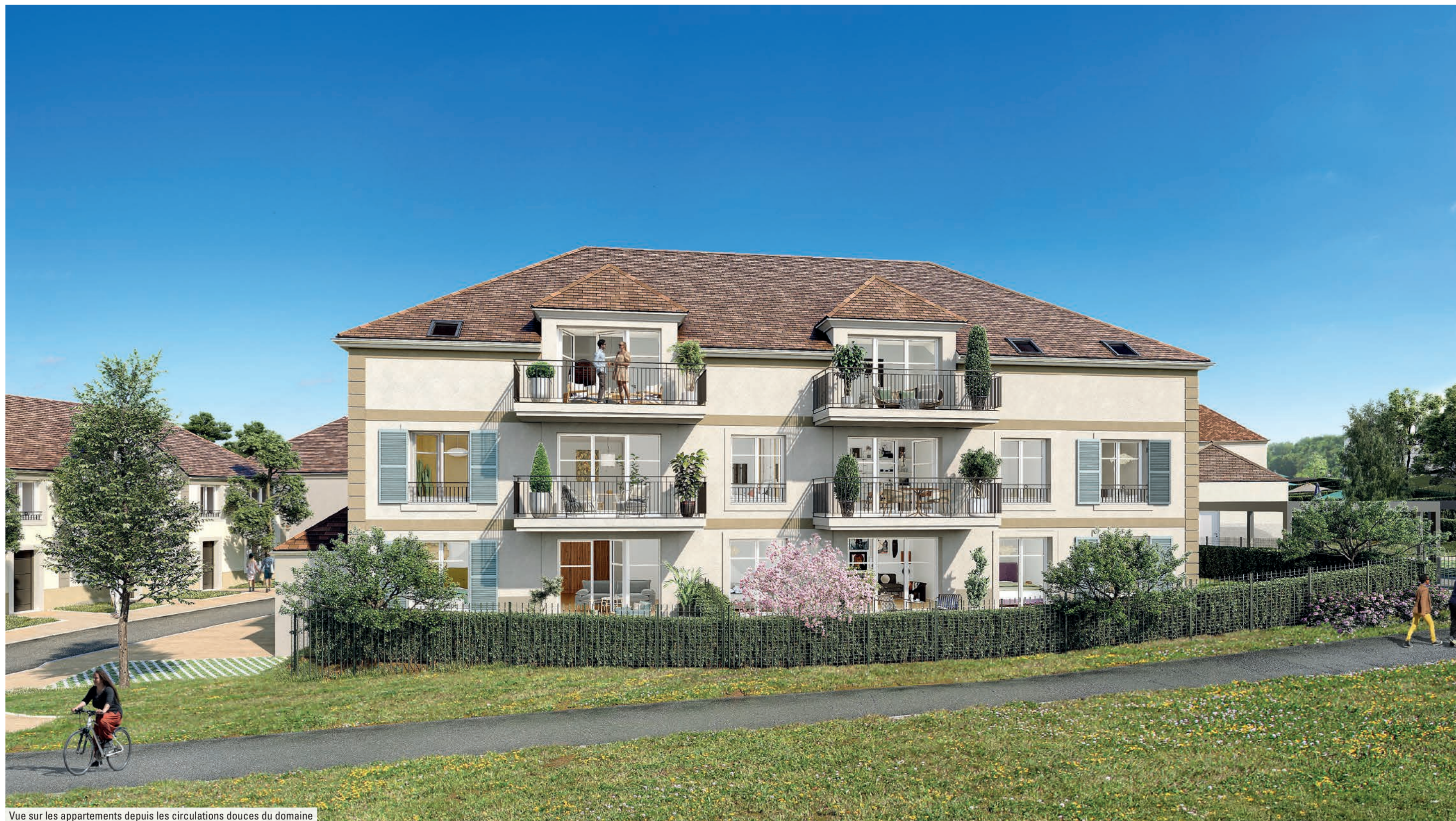
Vue sur les appartements depuis les circulations douces du domaine
