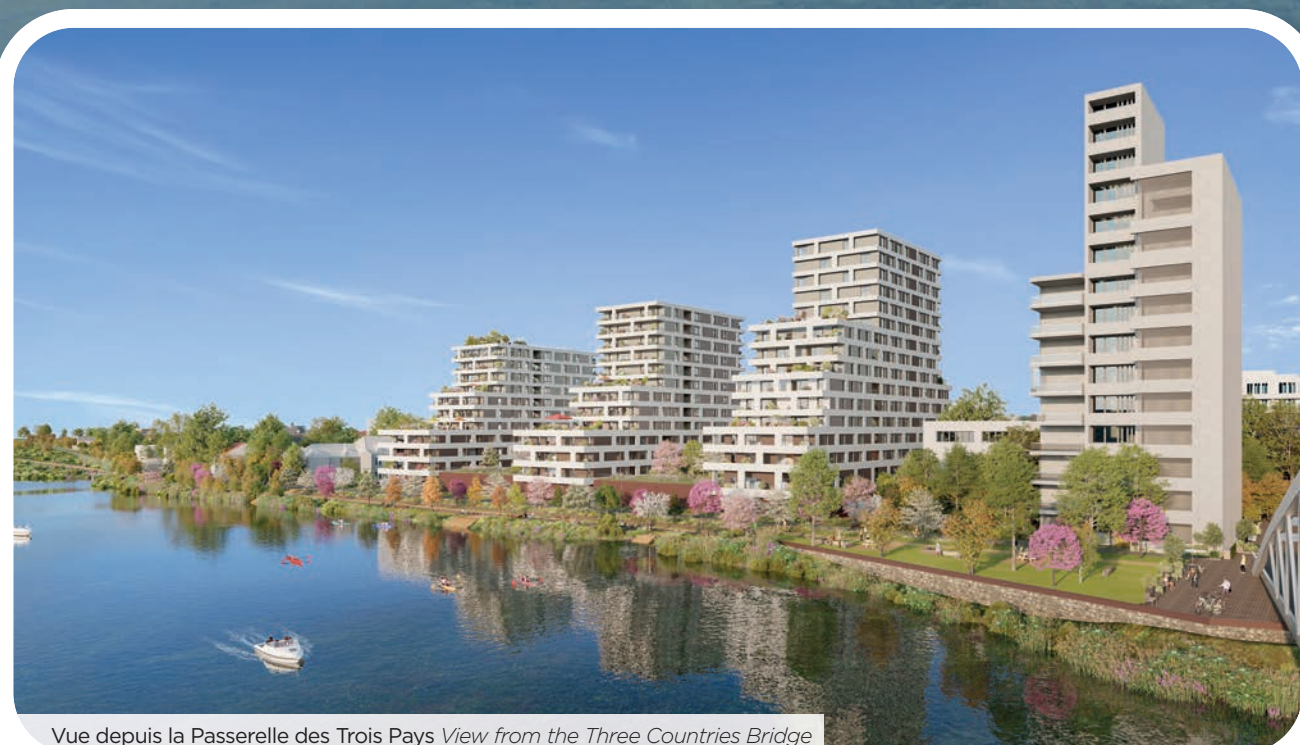
Vue depuis la Passerelle des Trois Pays View from the Three Countries Bridge
