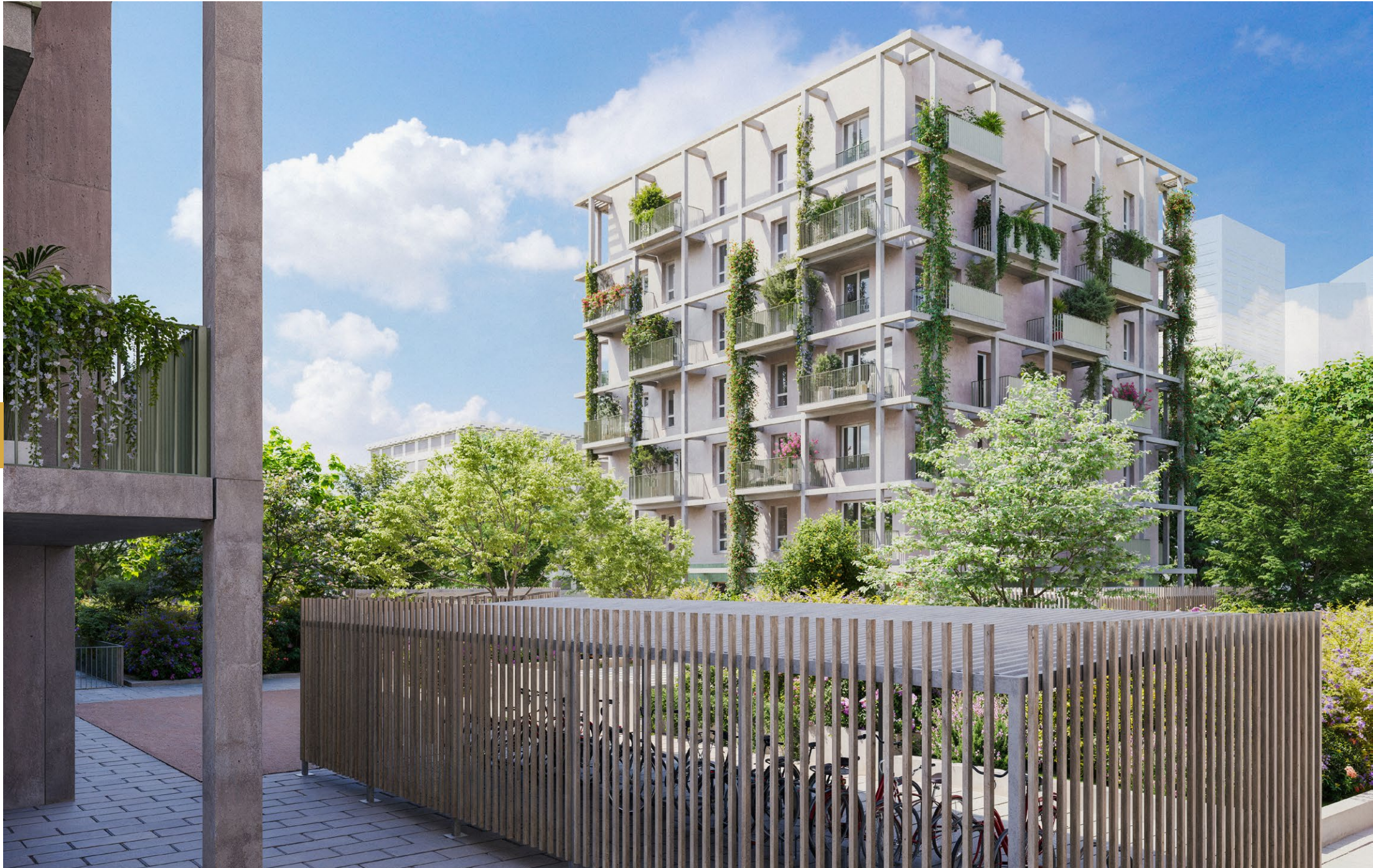
Vue du bâtiment C de la résidence
